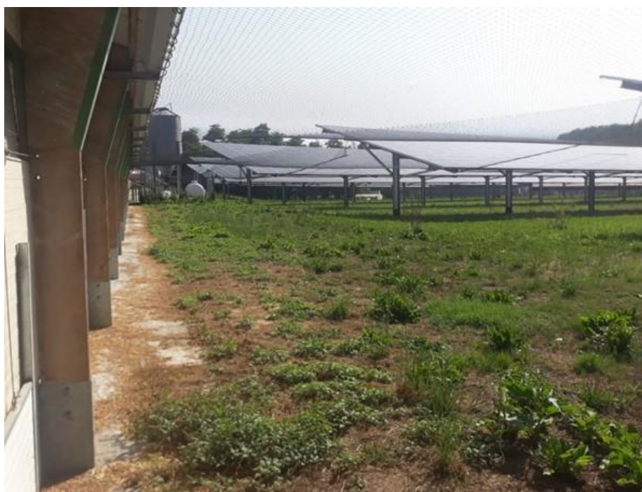
Figure 4 : Photographie d'une volière agrivoltaïque de Technique Solaire dans le cas d'un élevage de poulets de chair, avec à gauche le bâtiment d'élevage relié directement aux panneaux solaires et à la clôture périphérique, formant un clos total.
